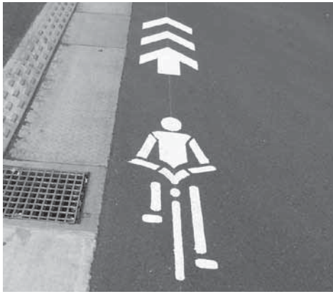
写真① 警視庁が独自に設定した自転車ナビマーク。自転車利用者に対して自転車の走行する場所と進むべき方向を示すだけでなく、ドライバーに対しても自転車が車道を通行するということを改めて意識させる効果がある
